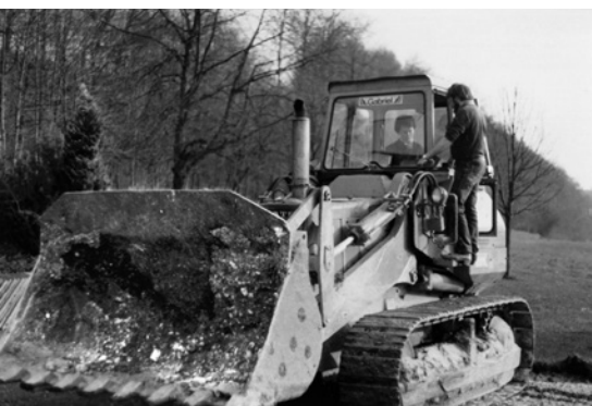
Frau Flückiger beim Spatenstich für den Anbau Speisesaal und Cafeteria 1983
