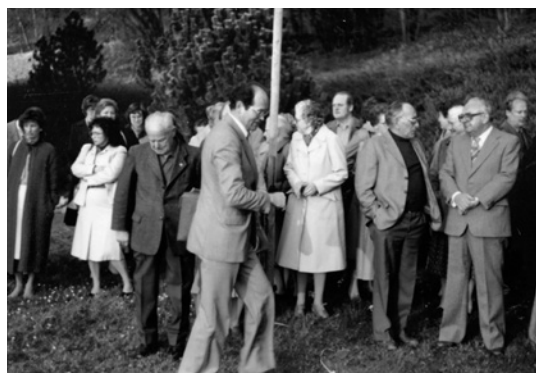
Die Gäste beim Spatenstich
